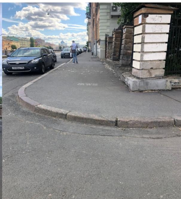
При съезде с тротуара на проезжую часть есть перепады высот: **Перепад высот в местах съезда и подъема на проезжую часть ул. Циолковского - 0,12 м.**
